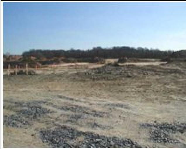
그림 17. 부지 정지 작업
