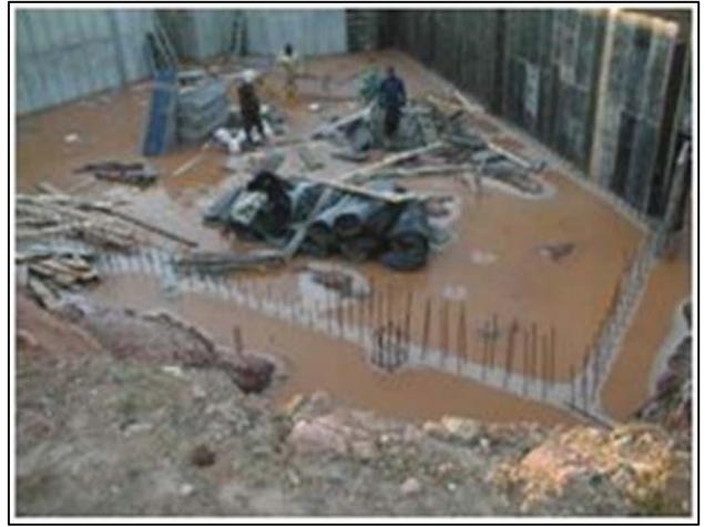
그림 20. 뽕뽕 얼어버린 기초 공사 현장
