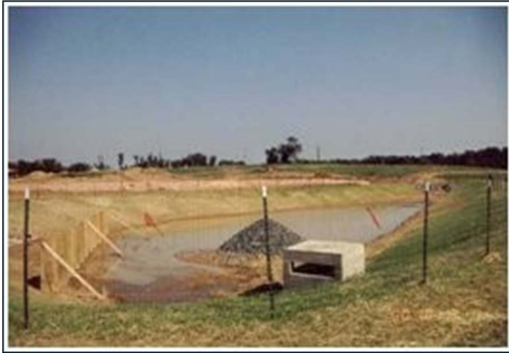
그림 15. 퇴적물 및 폭우 관리 시설 공사
